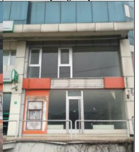
Güney Cephesi Boş Dükkan
