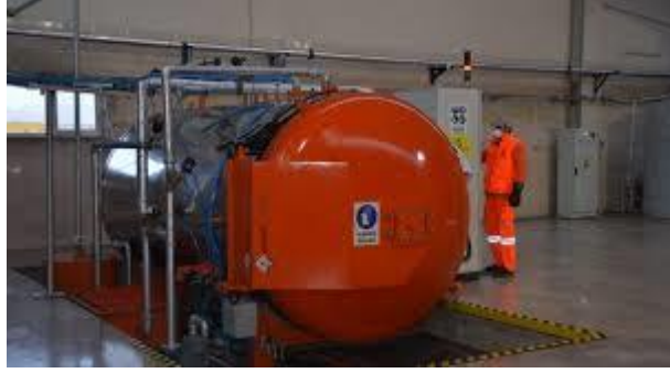
Resim 2.16: Sterilizasyon Tesisi Çalışmalarından Bir Görüntü
