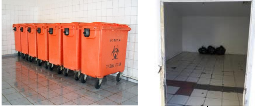
Resim 2.9: Tıbbi Atık Ve Evsel Atık Geçici Depolamanın İç Görüntüsü
