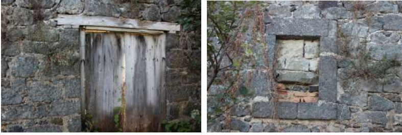
Şekil 8. Konutun doğu cephesine ait detaylı görünüşleri
