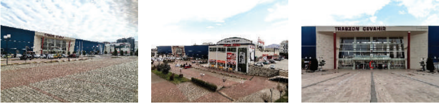
Şekil 7. Cevahir Outlet Alışveriş Merkezi dış mekândan görünüşler (Erbay, 2021)
