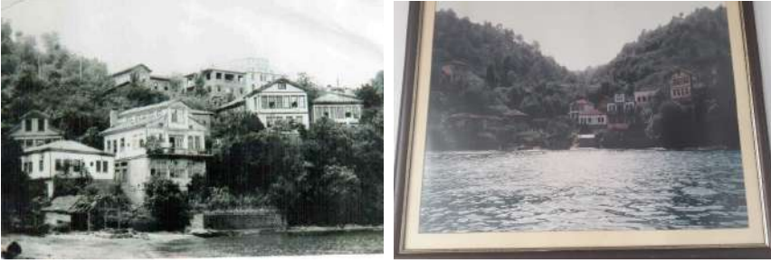
Şekil 3.Yapının 1960'lı, 1970'li yıllardaki görünümü (Zan Mimarlık, 2018)
