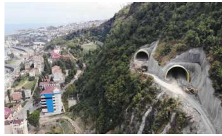
Boztepe tünel çalışması
