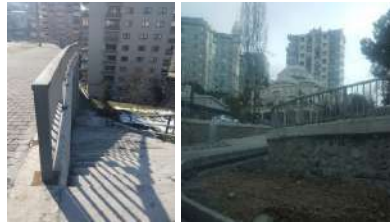
Oluşan basamaklı merdivenler
